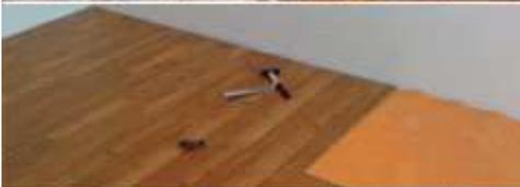
\* Con la pieza residual de la 1ª hilera se empieza de nuevo la instalación de la próxima hilera.
