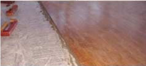
\* Las tarimas se instalan con el lado de la lengüeta hacia la pared. Guardando una distancia hacia la pared de 10 a 15 mm. (dilatación).
