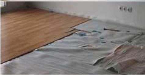
\* A continuación levantar la membrana por la pared y, tras la instalación de los zócalos/rodapiés cortarla a ras del borde superior de éstos. La membrana debe solaparse 30 mm. en las zonas de unión.
