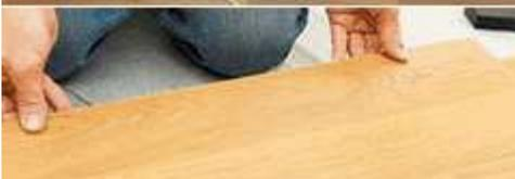
\* A fin de guardar la distancia hacia los bordes, se instalará un sistema de perfil en transiciones de la puerta a otra habitación o dependencia. El carril debe ser guardado una distancia de dilatación de 5mm.
